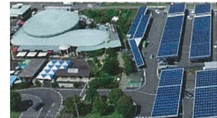
太陽光発電施設の設置
