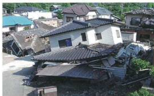
地震による被害例（熊本地震）
